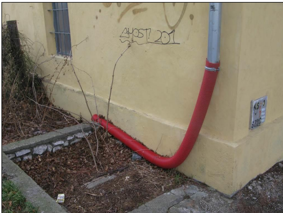
Obr. č. 11 - pohled na provizorní řešení okapového svodu u severozápadní, kratší zdi objektu.
