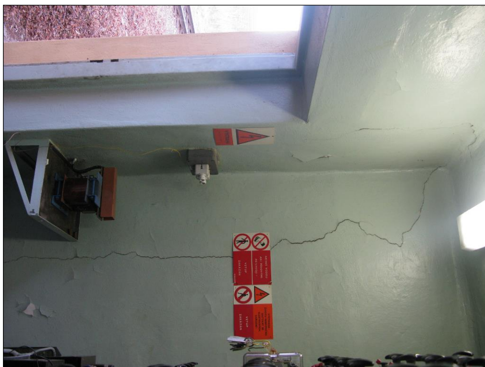
Obr. č. 6 - pohled na průběžnou trhlinu v líci vybrané zdi v místnosti s bateriemi ZZ.
