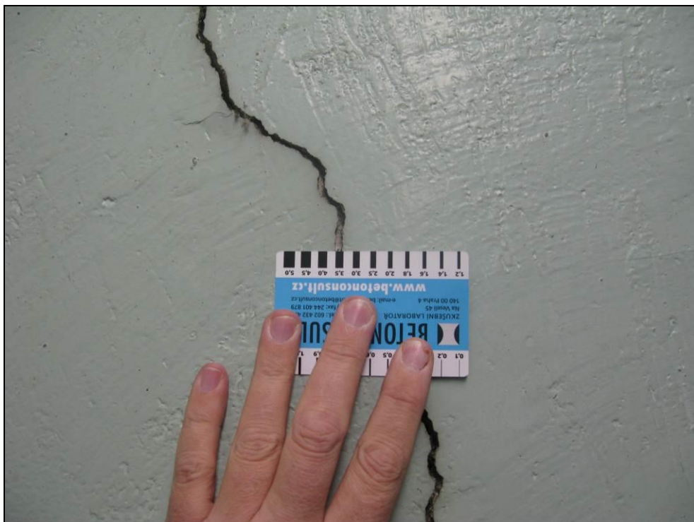
Obr. č. 7 - pohled na měření trhlín v místnosti s bateriemi ZZ.
