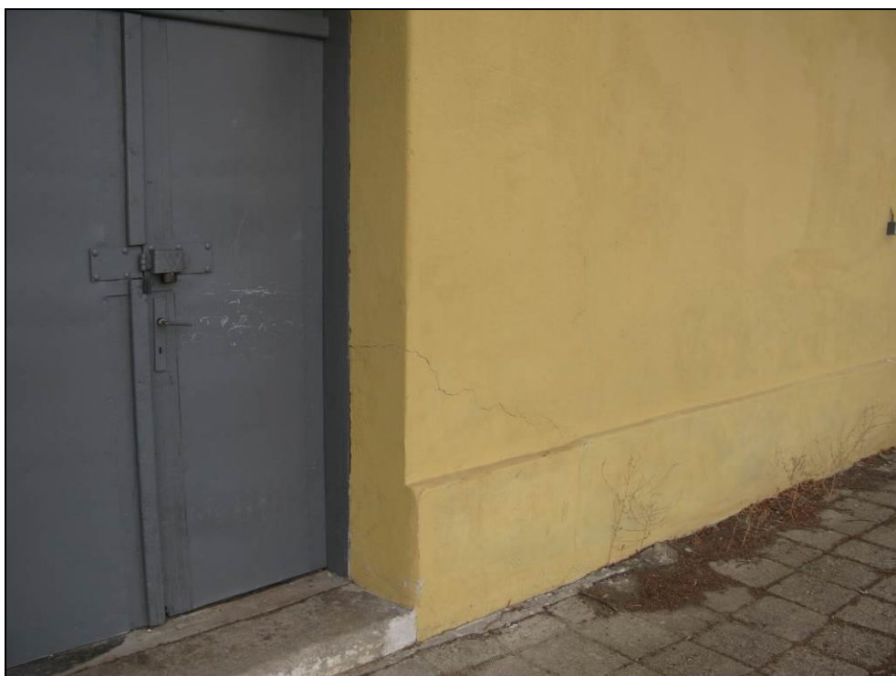
Obr. č. 10 - pohled na průběžnou trhlinu na vnějším líci nosné zdi orientované směrem do kolejiště.
