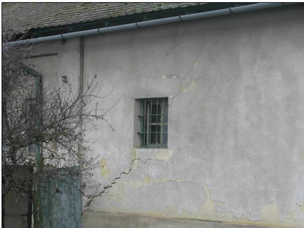
Obr. č. 9 - pohled na průběžnou trhlinu přes okenní otvor na vnějším líci „nerekonstruované“ nosné zdi.
