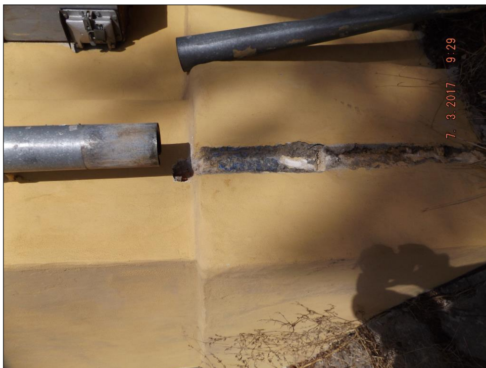
Obr. č. 12 - pohled na „sekanou“ sonda SO2 do vnějšího líce nosné, jihovýchodně orientované zdi stavby pro ověření existence hydroizolace. Hydroizolace nebyla sondou zastižena.
