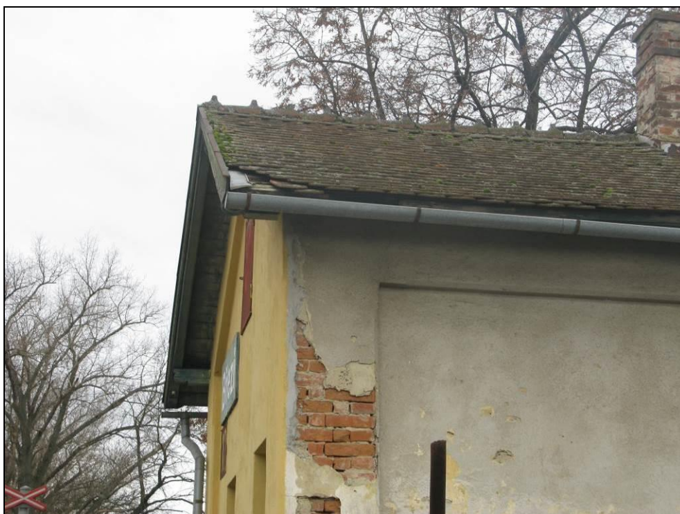
Obr. č. 8 - pohled na opady omítky a obnažené cihelné zdivo v lící „nesanované“ nosné zdi objektu. Střešní tašky jsou nad čelní zdí uvolněné a na nároží zatéká.
